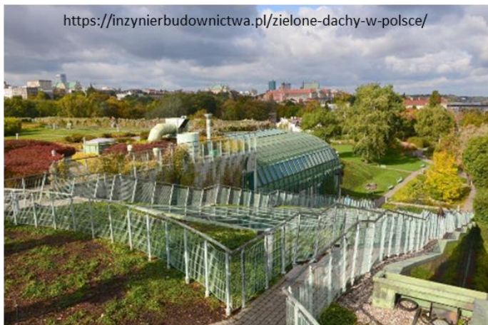
Dach Biblioteki Uniwersytetu Warszawskiego, fot. BUW
